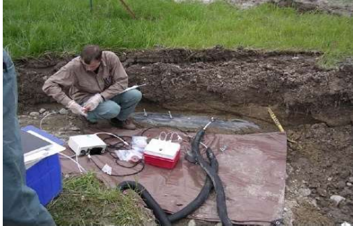
Raw Landfill Gas Collection Pipe
